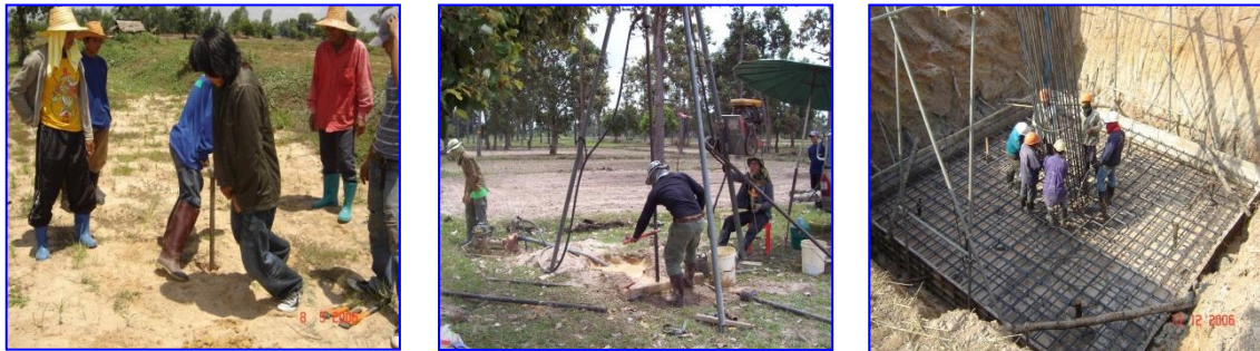
ขั้นตอนที่ 2 - 4 งานเจาะสำรวจชั้นดิน งานตัดต้นไม้ และงานก่อสร้างฐานราก
